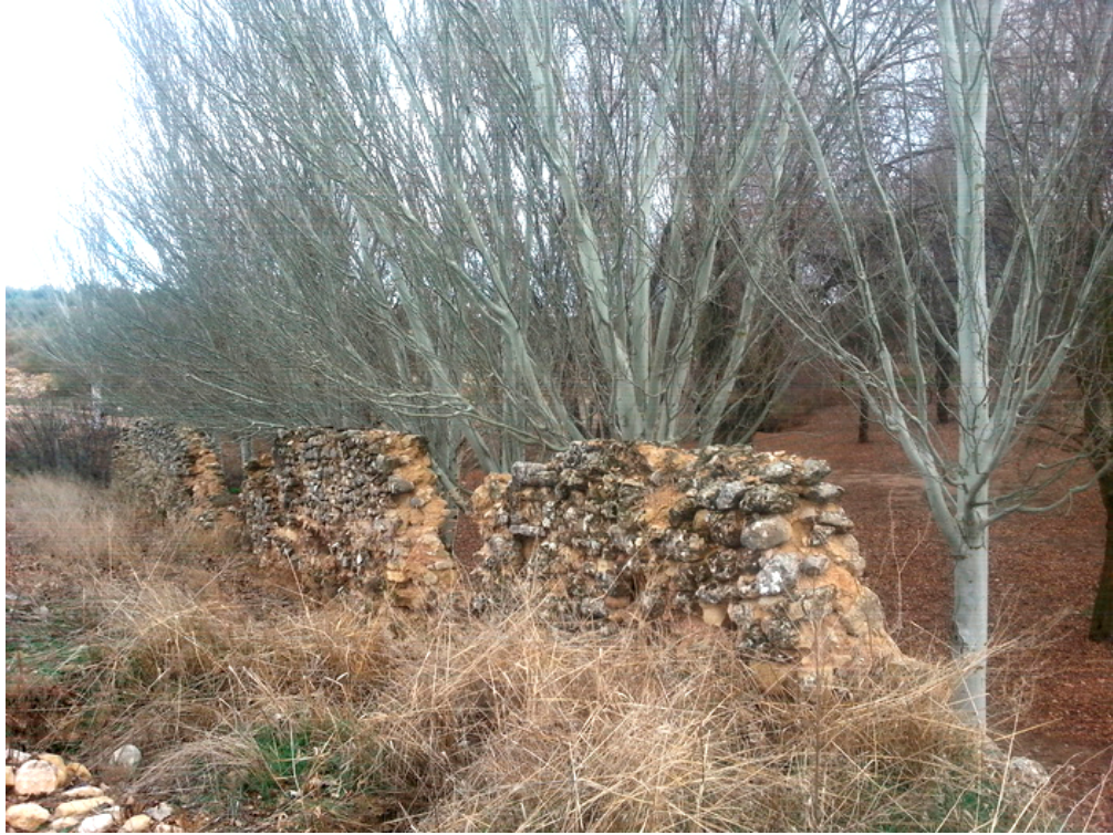
Acueducto de la Fuente de la Peña
