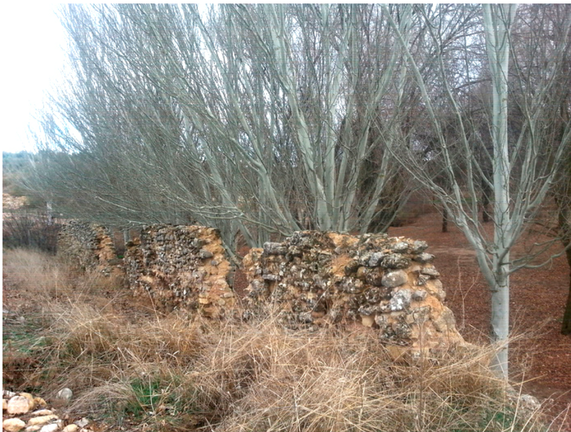
Acueducto de la Fuente de la Peña
